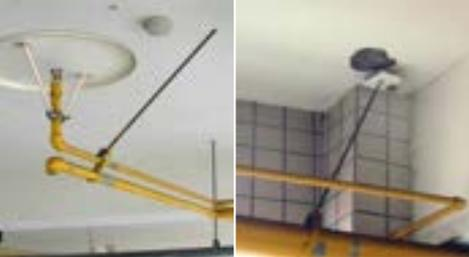
消防自動灑水系統耐震性不足斷裂造成漏水，導致懸吊式輕鋼架天花板吸水後載重過大而崩塌。
