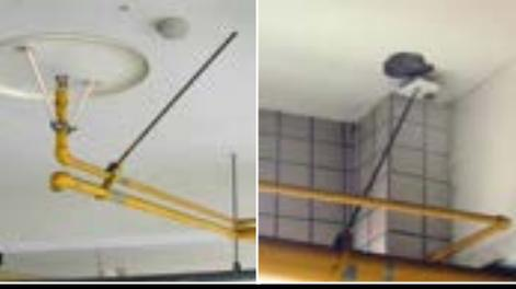
空調系統之冰水管因為與消防管過於靠近，故冰水管於地震中撞擊消防管而受到損壞，導致室內嚴重淹水影響空間機能。
