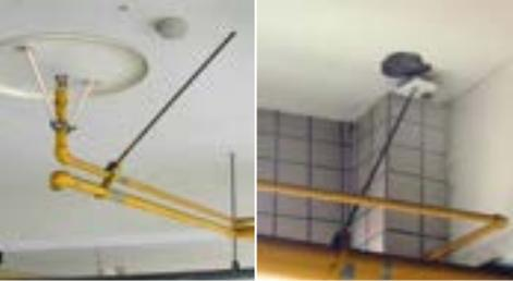
管線接點及管線吊桿耐震性不足影響消防管線正常運作。
