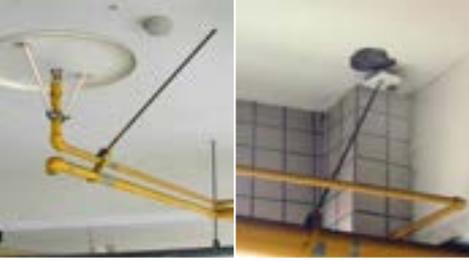
1999集集地震之破壞型式主要可分為「吊桿破壞」及「配管破壞」兩種。
