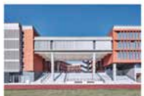
上海复旦大学实验楼
