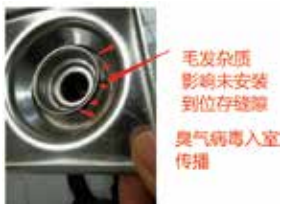
图2 常见深水封地漏组件安装
