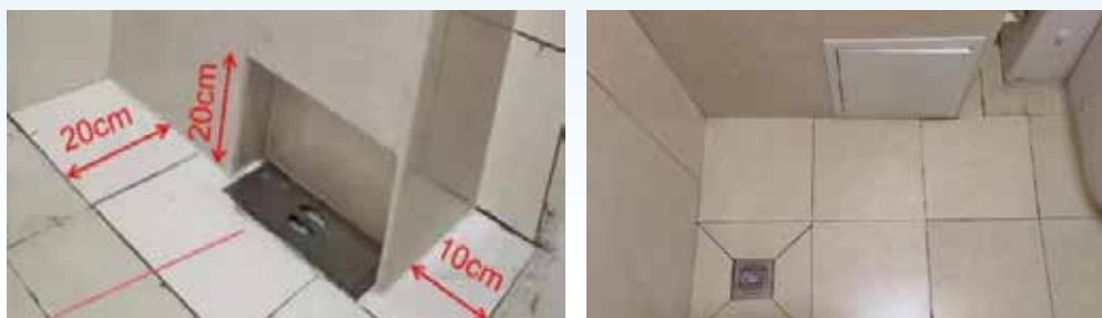
图6 a集中水封作为地漏
