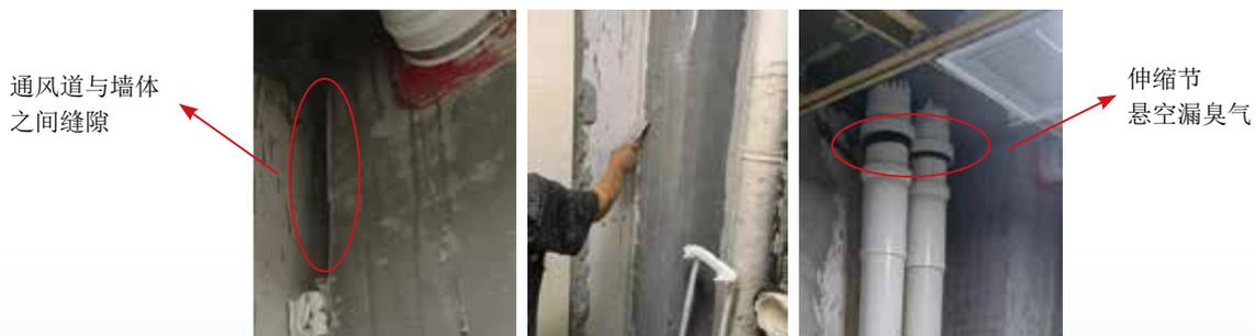
图1 伸缩节及通风道密封问题及维修
