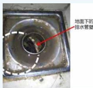
图10 洗衣机地漏错位断接
