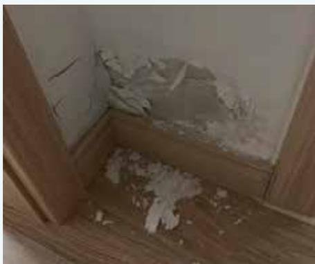
图3 同层水平串水阴墙鼓包
