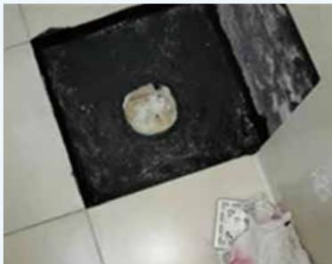
图9 淋浴地漏与管口断接
