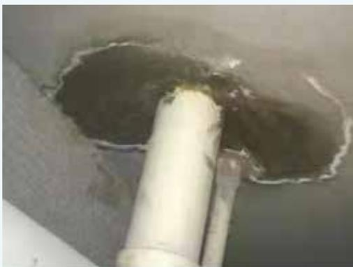
图2 上下层间垂直漏水
