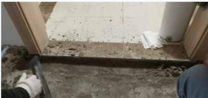
2) 在卫生间门口将地板拆除、将垫层拆除，涂刷防水涂料与原防水层结构，形成第二道阻拦，进一步加强抗渗效果。
