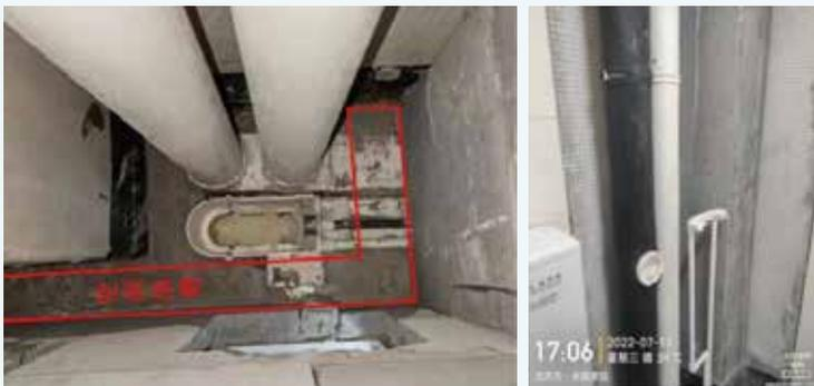
图2 管道井包封尺寸过大
