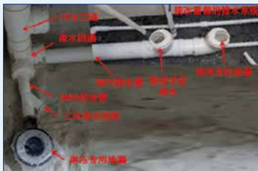
图1 同层排水管道系统图
