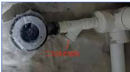
图10 采用三通顶部钻孔二次排水结构
