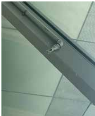
图8 玻璃幕墙侧面喷头安装
