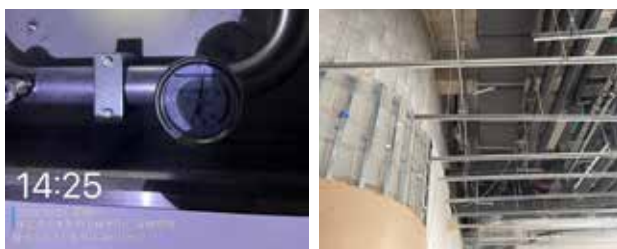
图5 承插压合式薄壁不锈钢管道高压细水雾安装图为承插压合式。
