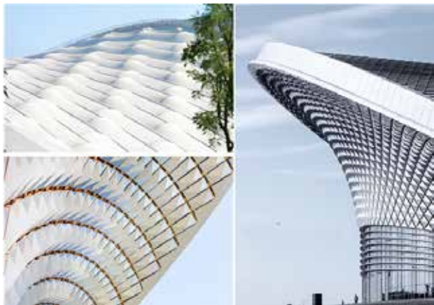
图4 凤冠造型、屋面膜结构实景图
