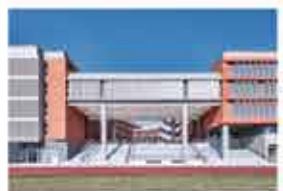
上海复旦大学实验楼
