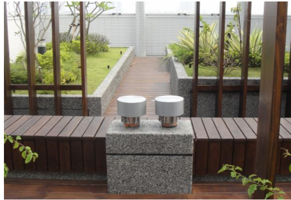
圖 16 伸頂通氣管安裝同徑吸氣閥例
