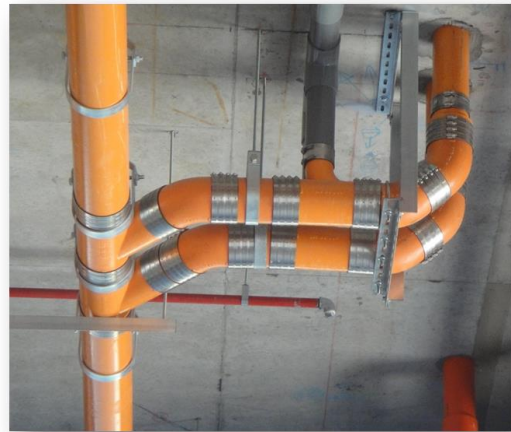
圖 21 排水立管正壓緩和之施工配管案例
