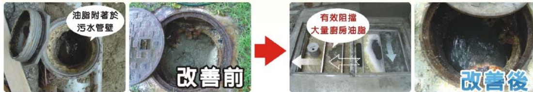
圖十一 汙水排放系統改善情形
