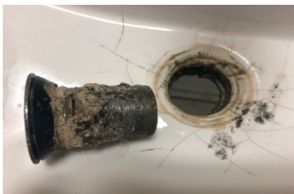
圖 8 洗臉盆落水口清除物（油、污泥）
